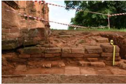
〈그림 11〉 파야똥주 원 기반부 조적 상태
